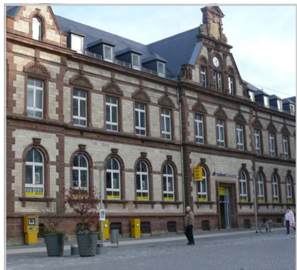
Historisches Post Gebäude in Gera
