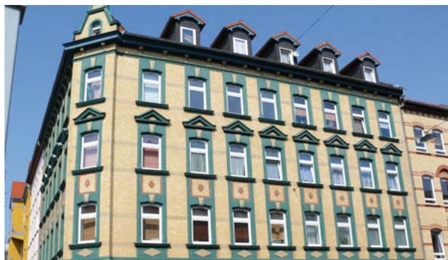
Erfurt, Wohn- und Geschäftshaus
