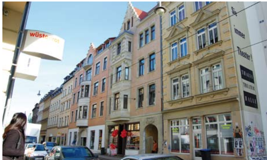
Halle, Wohn- und Geschäftshaus
